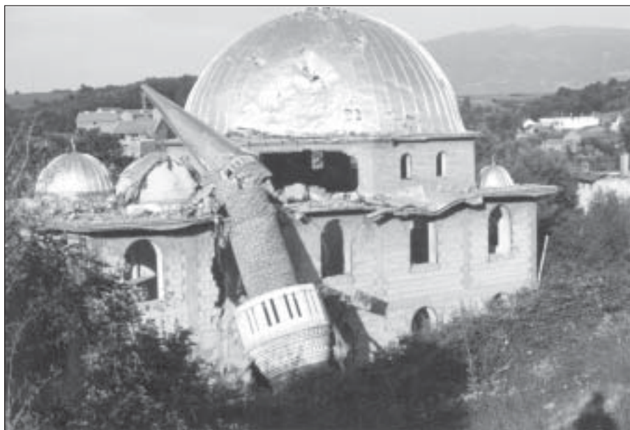
Një xhami e shkatërruar në rrugën Prizren-Gjakovë, korrik 1999
